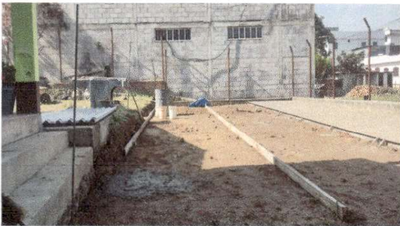
Foto 3: fundición de piso de torta
