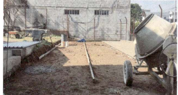
Foto 2: fundición de piso de torta
