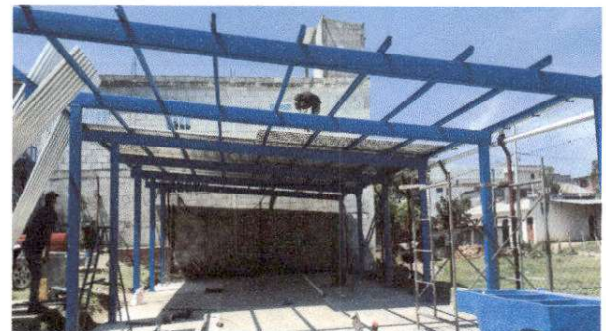
Foto 4: inicio de estructura metálica y colocación de lámina
