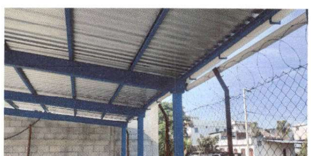
Foto 6: instalación de canales de caída de agua
