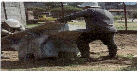
Foto 5: cambio de pila
